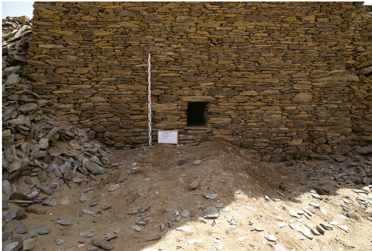
Рисунок 15. Фрагмент стены Северной крепости, сложенный из плит кристаллического сланца и конгломерата. В центре - квадратное отверстие, ведущее в Помещение 1 Figure 15. Wall of the Northern Fortress built of the slate slabs. In the center – opening to the Room 1
